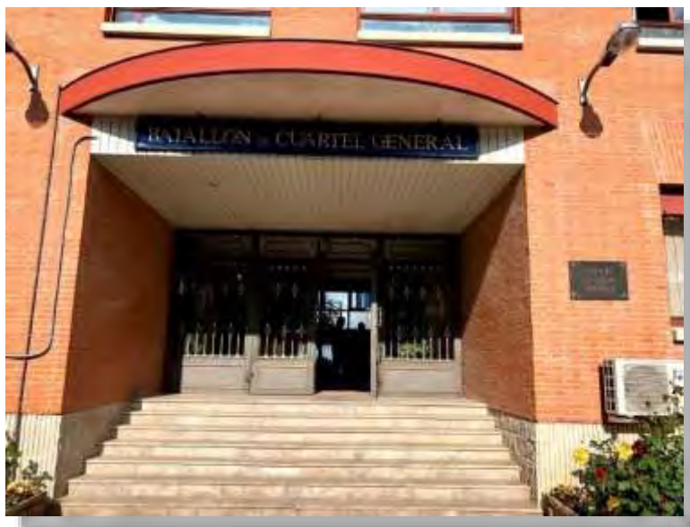
Edificio “SARGENTO ESTEBAN” del BCGFAMET
