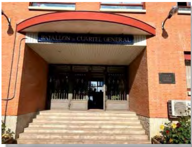
Edificio “SARGENTO ESTEBAN” del BCGFAMET
