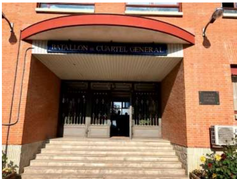
Edificio “SARGENTO ESTEBAN” del BCGFAMET
